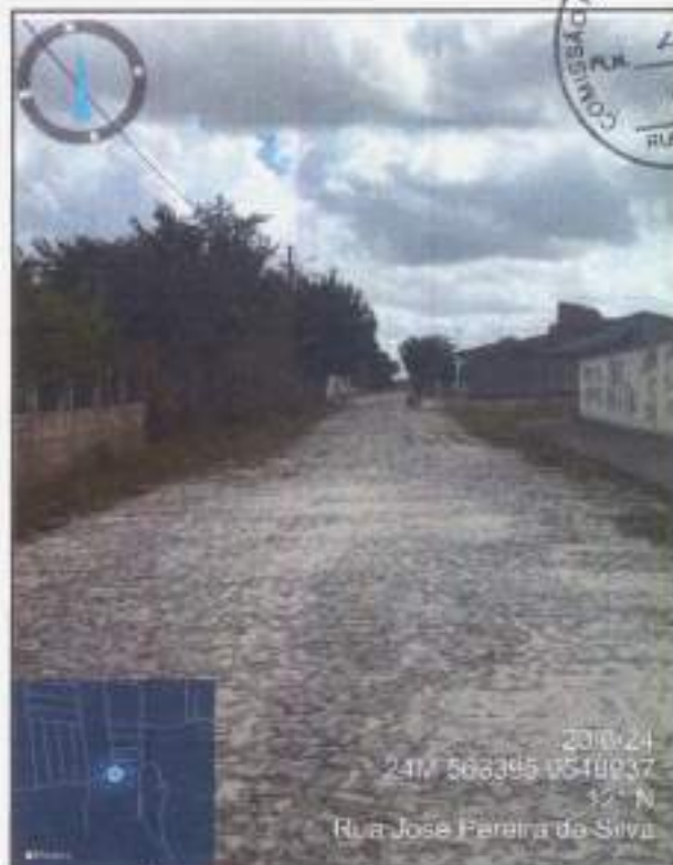
FOTO N° 2010/24 24M-563395-0549037 132.78 Rua José Pereira da Silva 14 RUA JOSÉ PEREIRA DE OLIVEIRA CANAVIEIRA DOS PINHEIROS
