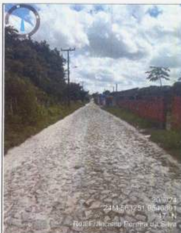
FOTO N° 2010/24 24M-561251-0546801 137.78 Rua Francisco Pereira da Silva 16 RUA FRANCISCO PEREIRA DA SILVA CANAVIEIRA DOS PINHEIROS
