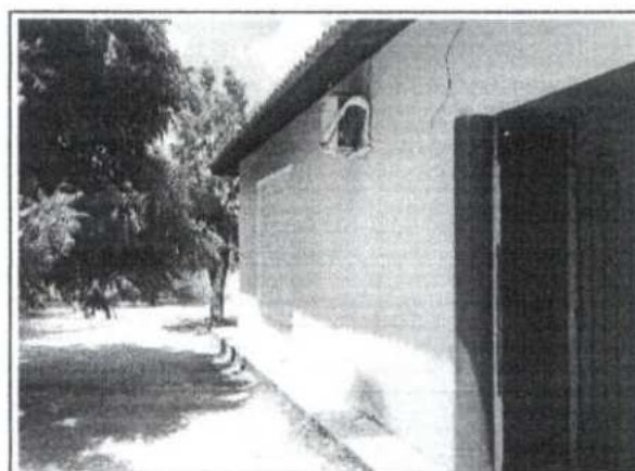
FOTO Nº REVESTIMENTOS 12 JANEIRO 2024
