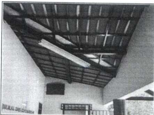
FOTO Nº INSTALAÇÕES ELÉTRICAS 18 JANEIRO 2024
