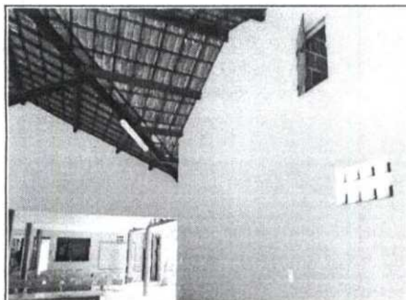
FOTO Nº REVESTIMENTOS 9 JANEIRO 2024
