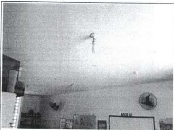
FOTO Nº REVESTIMENTOS 13 JANEIRO 2024
