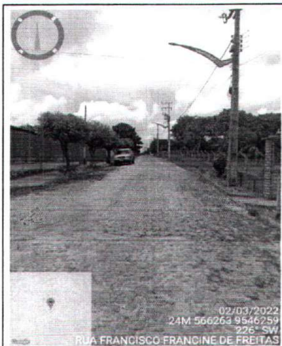
FOTO Nº PAVIMENTAÇÃO EXISTENTE 4 DISTRITO DE ANINGAS
