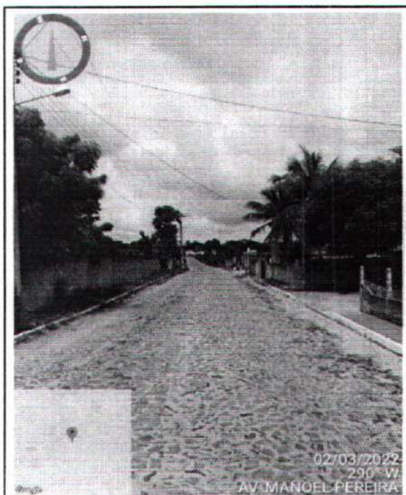
FOTO Nº PAVIMENTAÇÃO EXISTENTE 11 DISTRITO DE ANINGAS
