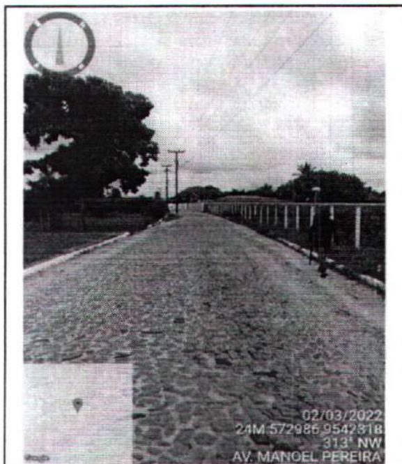
FOTO Nº PAVIMENTAÇÃO EXISTENTE 13 DISTRITO DE ANINGAS
