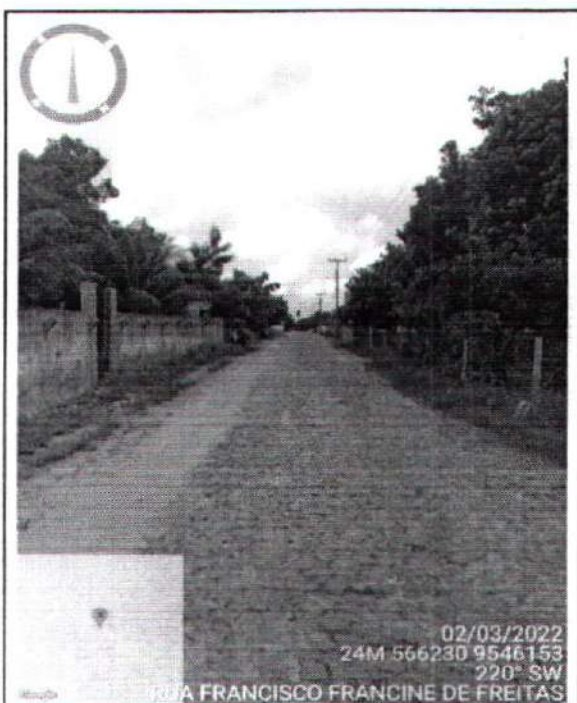
FOTO Nº PAVIMENTAÇÃO EXISTENTE 3 DISTRITO DE ANINGAS
