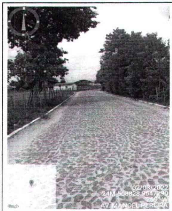
FOTO Nº PAVIMENTAÇÃO EXISTENTE 16 DISTRITO DE ANINGAS
