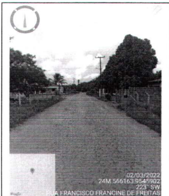
FOTO Nº PAVIMENTAÇÃO EXISTENTE 1 DISTRITO DE ANINGAS
