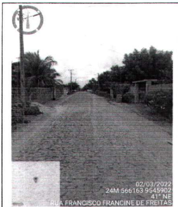
FOTO Nº PAVIMENTAÇÃO EXISTENTE 2 DISTRITO DE ANINGAS
