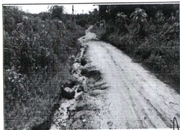
FOTO Nº DRENAGEM LAGOINHA 17 JUNHO 2022
