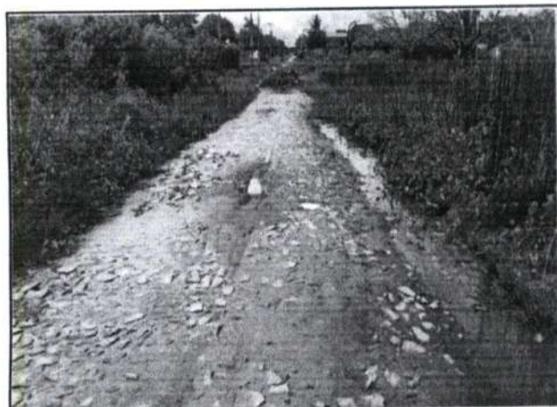
FOTO Nº DRENAGEM LAGOINHA 15 JUNHO 2022
