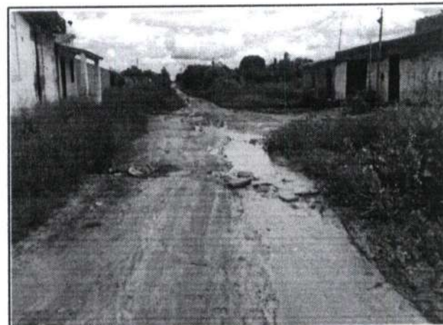
FOTO Nº DRENAGEM LAGOINHA 10 JUNHO 2022
