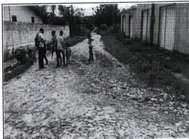
FOTO Nº DRENAGEM LAGOINHA 16 JUNHO 2022
