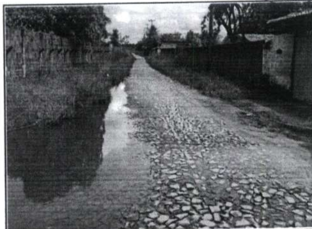
FOTO Nº DRENAGEM LAGOINHA 14 JUNHO 2022
