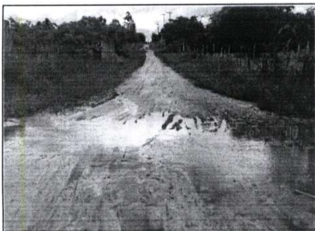
FOTO Nº DRENAGEM LAGOINHA 7 JUNHO 2022
