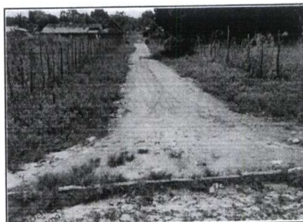
FOTO Nº DRENAGEM LAGOINHA 18 JUNHO 2022
