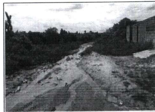
FOTO Nº DRENAGEM LAGOINHA 12 JUNHO 2022
