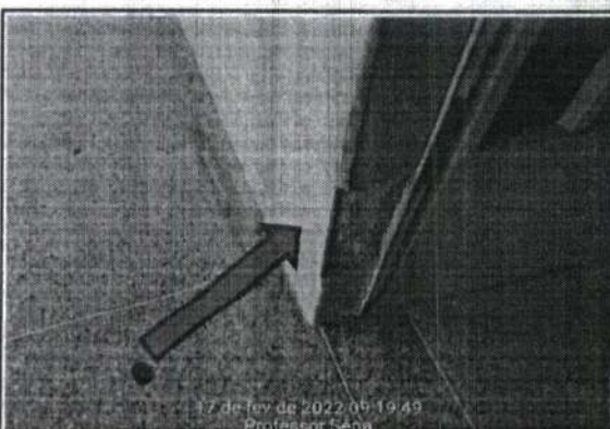
FOTO Nº SUBSTITUIÇÃO DE CANTONEIRAS EXISTENTES
