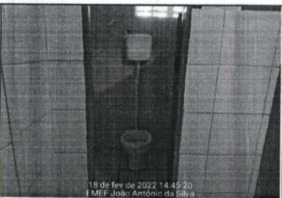
FOTO Nº 59 INSTALAÇÃO DE CAIXA DE DESCARGA ETAMPA DE VASO
