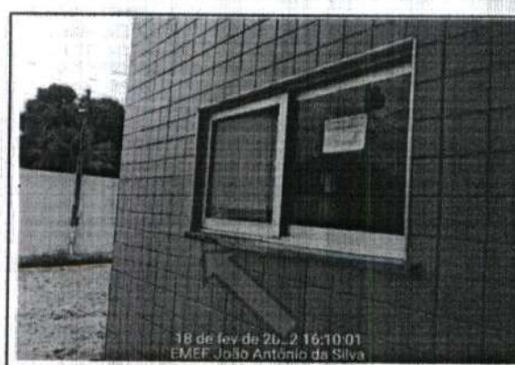
FOTO Nº 36 SUBSTITUIÇÃO DE PEITORIL DA GUARITA
