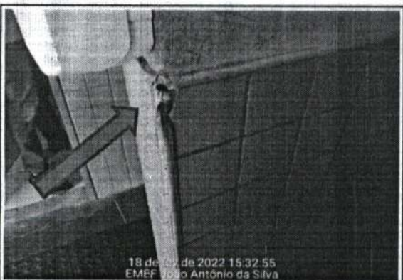
FOTO Nº SUBSTITUIÇÃO DE CANTONEIRAS EXISTENTES
