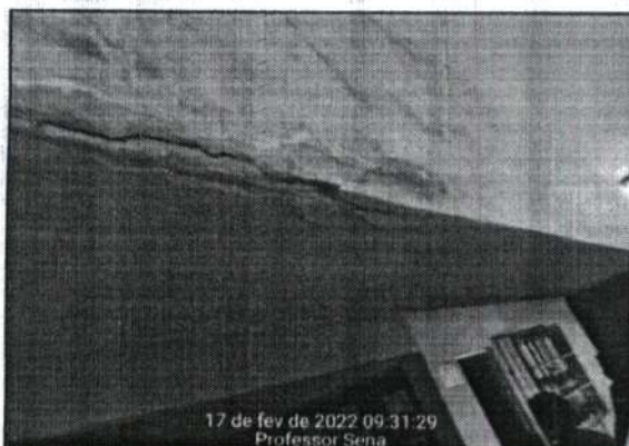
FOTO Nº 33 RECUPERAÇÃO ESTRUTURAL CALHA
