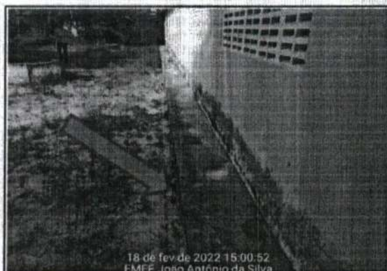
FOTO Nº RECUPERAÇÃO DE CALÇADAS DE PERÍMETRO 38
