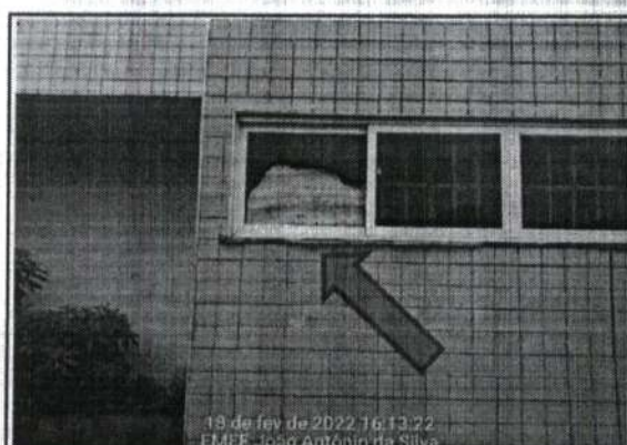
FOTO Nº 34 SUBSTITUIÇÃO DE PEITORIL DA GUARITA
