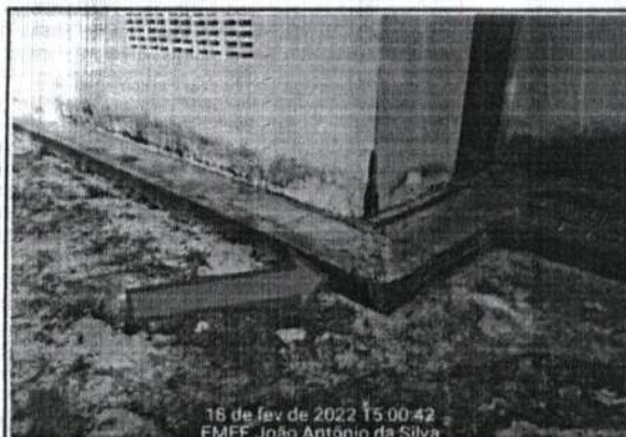
FOTO Nº RECUPERAÇÃO DE CALÇADAS DE PERÍMETRO 37
