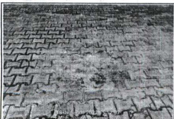
FOTO Nº RECOMPOSIÇÃO DE PISO INTERTRAVADO 41
