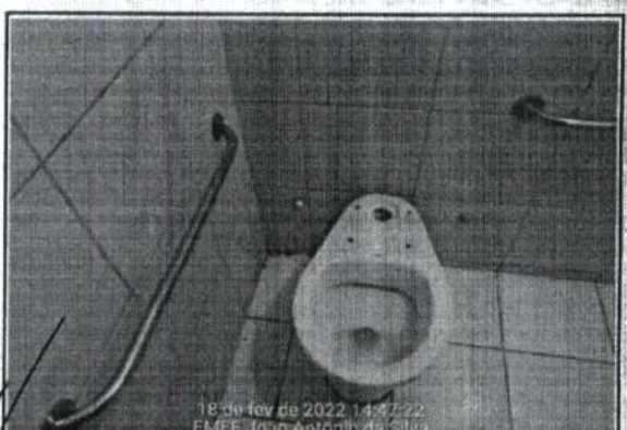
FOTO Nº 60 SUBSTITUIÇÃO DE BACIA SANITÁRIA
