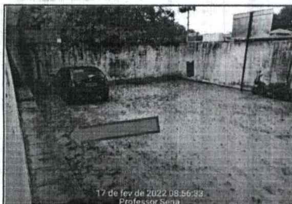
FOTO Nº RECUPERAÇÃO DE CALÇADAS DE PERÍMETRO 39
