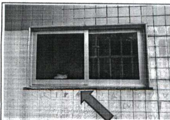
FOTO Nº 35 SUBSTITUIÇÃO DE PEITORIL DA GUARITA
