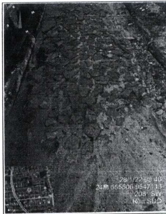
FOTO Nº BAIRRO CENTRO 144 RUA SDO
