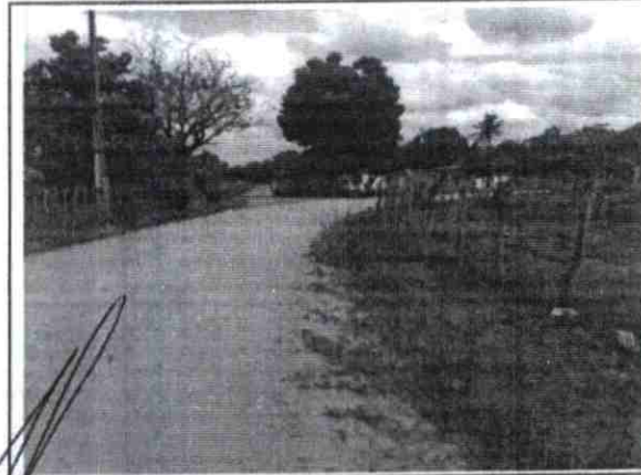
FOTO N° RUA MARIANO PEREIRADA COSTA 6 LAT: 4° 5'49.11"S / LONG: 38°24'17.08"O
