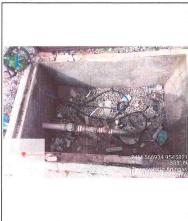
FOTO Nº POÇO COM BOMBA SUBMERSA 6 PRAÇA DE ANINGAS
