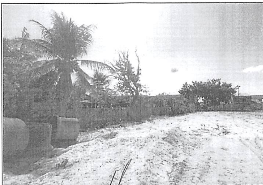
FOTO Nº MURO LATERAL ESQUERDO 4 HORIZONTE-CE
