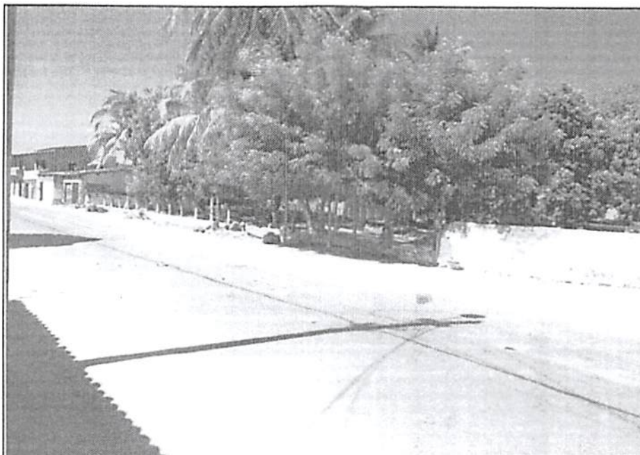
FOTO Nº MURO FRONTAL 3 HORIZONTE-CE
